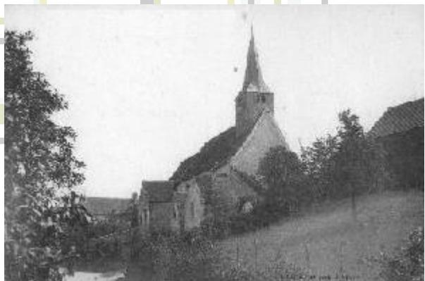
Le Clocher en charpente posé sur le comble de la nef au-dessus de la porte d'entrée présente un pavillon carré surmonté d'une pyramide à huit pans, le tout entièrement revêtu et couvert d'ardoises.
